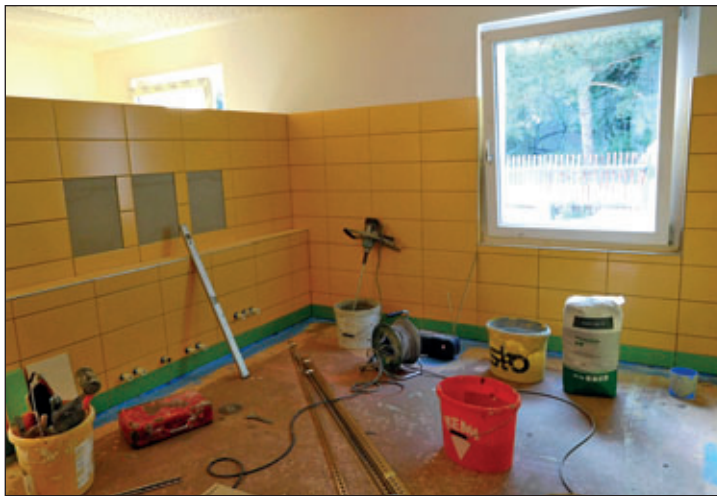
Das Bad der Kinderkrippe ist sehr farbig gewählt. Zu diesen gelben und grünen Fliesen wird ein grüner Kautschuk - Bodenbelag verlegt.
