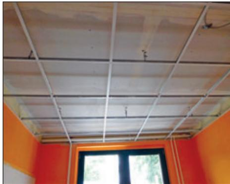
Mit der Schließzeit der Einrichtung begann der erste Bauabschnitt der Brandschutzertüchtigung im letzten Brandabschnitt. Nach dem Abbruch der vorhandenen Decken wurde eine Brandschutzdecke montiert. Darunter folgte eine neue Akustikdecke mit neuen Leuchten als LED. Die Maler erneuerten die Wandanstriche und so konnte die Küche und der halbe Flur sowie einzelne Nebenräume nach der Schließzeit wieder in Benutzung gehen.
