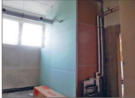
Die neue Akustikdecke und eine LED-Beleuchtung sind montiert. Das dafür notwendige Flächengerüst ist bereits wieder abgebaut. Der untere Bereich der Hallenwände kann jetzt maulermäßig instand gesetzt werden.
