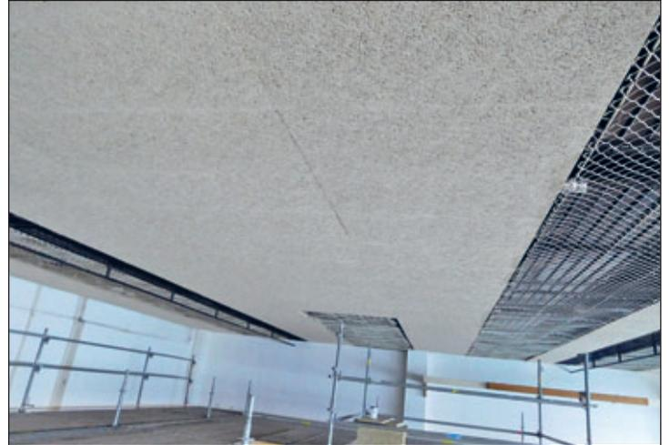
Hier ist der Blick vom Flächengerüst zur Hallendecke. Oberhalb des Maschengeflechtes befindet sich die Heizung der Halle, deswegen muss dieser Bereich weiterhin offen gestaltet sein. Längs in der Decke sind über die gesamte Länge zwei Lichtbänder mit neuen LED-Leuchten eingebaut. Die neue Akustikdecke ist ballwurfsicher. Die nicht einfache Deckenkonstruktion wurde vom Montagebetrieb Räubig GmbH aus Riesa eingebracht.
