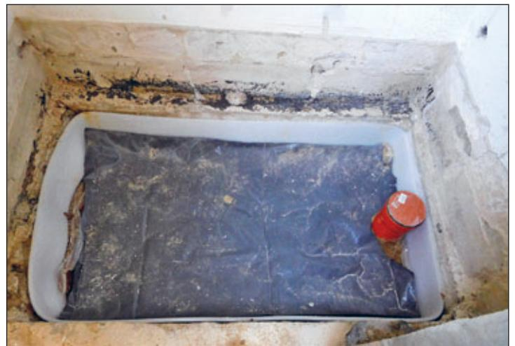
Eine völlig neue Grundleitung soll die Entwässerung für die nächsten Jahrzehnte wieder sicher und zuverlässig gestalten. Die verlegte Folie und der eingestellte Randdämmstreifen kündigen die Betonage der Bodenplatte an. Dies ist Mitte Juli geplant.
