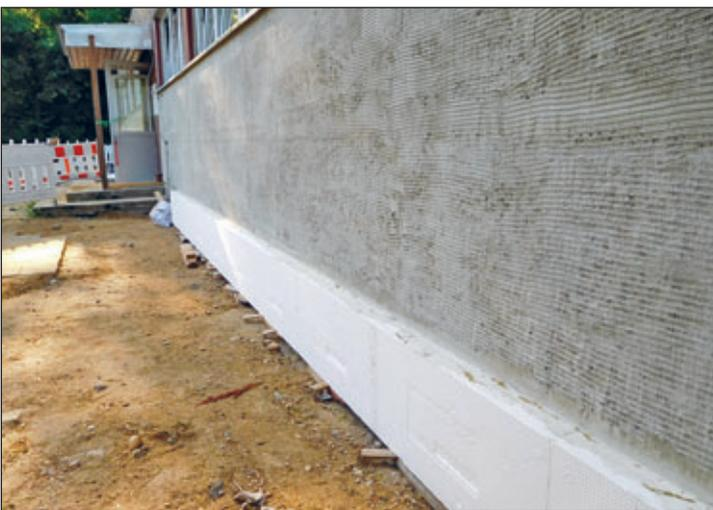
Die Außenwand am Parkplatz wird energetisch instandgesetzt. Dazu gehört u.a. eine Sockeldämmung und ein Grundputz, da die Fertigteil – Waschbetonplatten eine sehr unebene Oberfläche hatten. Mit den Bauhauptarbeiten ist die Firma Löwe & Schulz Bauunternehmung GmbH aus Lommatzsch beauftragt.
