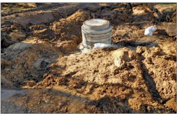
Das Foto oben zeigt den Behälter im Hintergrund, davor liegt die Abdeckung. Im Foto unten muss die Geländeoberfläche noch hergestellt werden. Danach ist nur noch der Deckel sichtbar.
