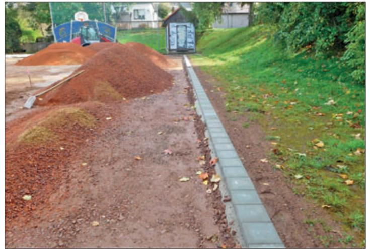
Die Laufbahn ist fertig vorbereitet für den Kunstbelag. Dieser verlangt trockenes Wetter zur Ausführung. Die Tennenfläche, siehe rechtes Foto, wird eingefasst, um den Bewuchs fernhalten zu können. Die Oberfläche wurde abgetragen und neu aufgefüllt.
