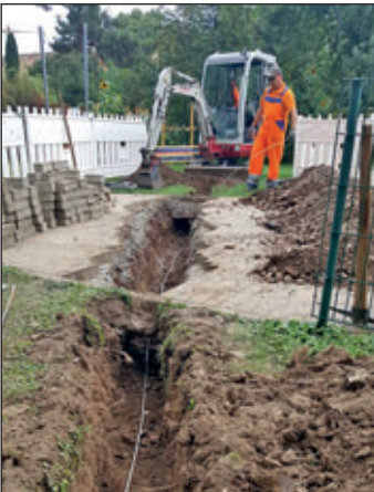
Tiefbauarbeiten für die Blitzschutzanlage der Kita Ziegenhain
