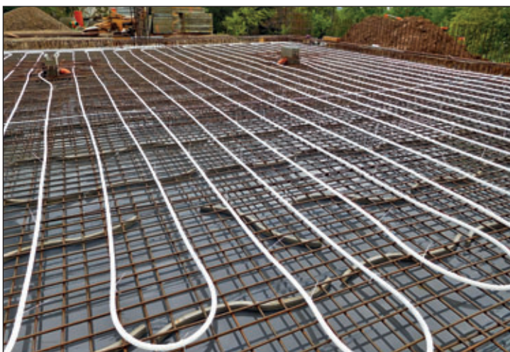
Im Bereich der Fahrzeughalle und der Werkstatt liegt die Bodenheizung in der Bewehrung und damit in der Bodenplatte. Die Heizung temperiert den Boden und ist selbst vor einer Belastung durch die Fahrzeuge geschützt. Mit der Ausführung dieser Heizung ist die Firma Haustechnik Jens Kohl aus Nossen OT Raußlitz beauftragt. Über den Heizleitungen wurde dann die obere Lage der Bewehrungseisen ausgeführt. Mitte Juni wurde die Bodenplatte betoniert.
