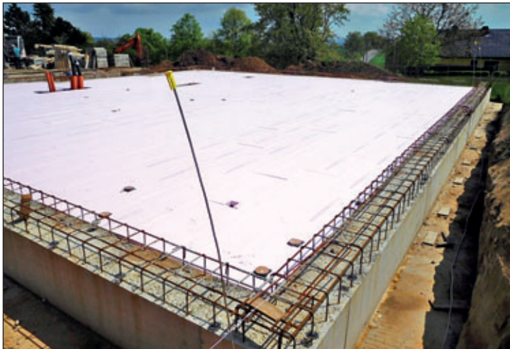
Unter der Bodenplatte ist die Wärmedämmung verlegt. Im Foto links sieht man diese rosafarben. Darauf wurde die untere Bewehrungslage angeordnet, siehe Foto rechts.
