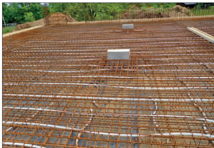
Im Bereich der Fahrzeughalle und der Werkstatt liegt die Bodenheizung in der Bewehrung und damit in der Bodenplatte. Die Heizung temperiert den Boden und ist selbst vor einer Belastung durch die Fahrzeuge geschützt. Mit der Ausführung dieser Heizung ist die Firma Haustechnik Jens Kohl aus Nossen OT Raußlitz beauftragt. Über den Heizleitungen wurde dann die obere Lage der Bewehrungseisen ausgeführt. Mitte Juni wurde die Bodenplatte betoniert.
