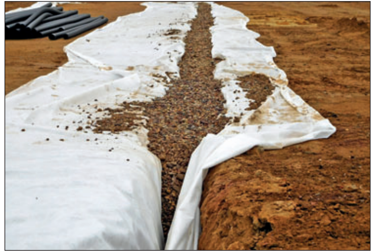
In der gesamten Fläche der Freisportanlage wird eine Flächendrainage hergestellt. Im Foto links verraten die weißen Streifen die Lage der Leitungen. Im Foto rechts sieht man, dass ein Vlies die Sickerpackung samt Drainageleitung umhüllt.
