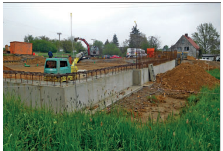
Die Frostschürze ist betoniert. Auf diesen Streifen wird die Bodenplatte für das Gebäude platziert. Die Verbindung zwischen beiden garantiert die herausschauende Bewehrung. Im Foto rechts sieht man die Frostschürze über dem momentan vorhandenen Gelände. Die Ursache ist die Hanglage des Grundstückes. Bis zur Fertigstellung des Gebäudes wird hier angeschüttet, so dass diese Bauteile im Erdreich sind.
