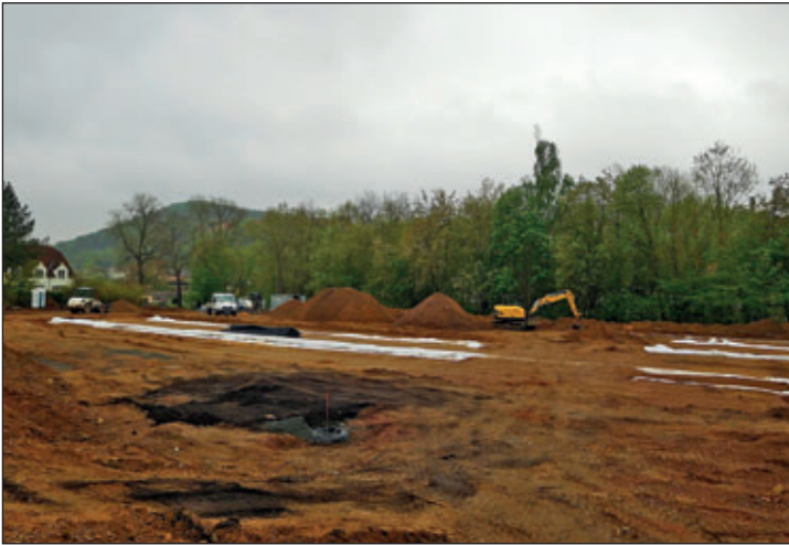
In der gesamten Fläche der Freisportanlage wird eine Flächendrainage hergestellt. Im Foto links verraten die weißen Streifen die Lage der Leitungen. Im Foto rechts sieht man, dass ein Vlies die Sickerpackung samt Drainageleitung umhüllt.
