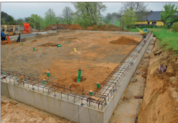
Die Frostschürze ist betoniert. Auf diesen Streifen wird die Bodenplatte für das Gebäude platziert. Die Verbindung zwischen beiden garantiert die herausschauende Bewehrung. Im Foto rechts sieht man die Frostschürze über dem momentan vorhandenen Gelände. Die Ursache ist die Hanglage des Grundstückes. Bis zur Fertigstellung des Gebäudes wird hier angeschüttet, so dass diese Bauteile im Erdreich sind.
