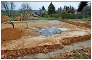
Die Mitarbeiter der Firma Riße haben mit dem ungünstigen Boden zu kämpfen. Immer, wenn es regnet oder schneit, wird ein Befahren des Baugrundstückes unmöglich. Das Foto zeigt, dass gerade eine Bodenstabilisierung durchgeführt wurde. Ungefähr 25 cm des lehmigen Bodens wurden mit Kalk vermischt, wieder eingebaut und verdichtet. Ein Baugrundgutachter prüft das Ergebnis der Maßnahme.
