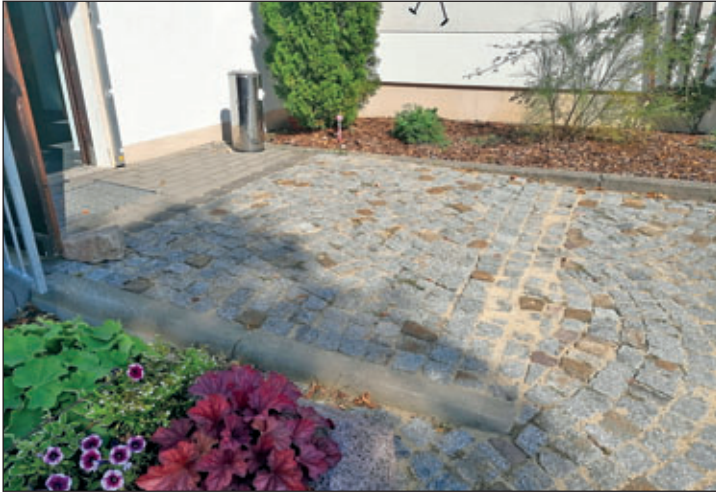
Durch die neu geschaffene Rampe wurde ein barrierefreier Zugang zur Badperle hergestellt.
