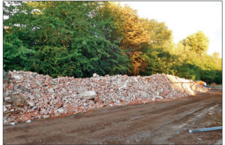
Von der ehemaligen Sporthalle ist nicht mehr viel übrig. Ein Rest der Stahlkonstruktion und ein großer Haufen abgebrochener Ziegel warten auf die Container. Die Baumaterialien wurden sauber getrennt für die Entsorgung.
