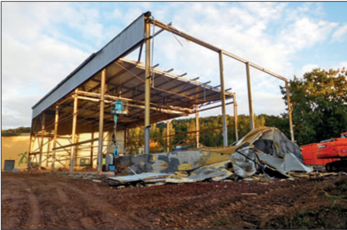
Von der ehemaligen Sporthalle ist nicht mehr viel übrig. Ein Rest der Stahlkonstruktion und ein großer Haufen abgebrochener Ziegel warten auf die Container. Die Baumaterialien wurden sauber getrennt für die Entsorgung.
