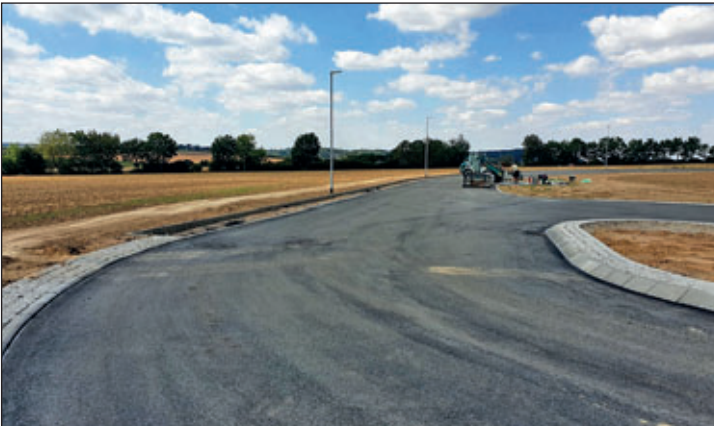
Baustand kurz vor Fertigstellung im Juli 2020
