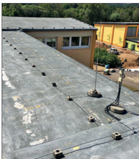
Die Oberschule hat in der Vergangenheit eine Dachsanierung mittels PUR-Hartschaum erhalten. Darauf ist ein Schutzanstrich gegen UV – Strahlung und Aufbringen von Splitt erforderlich. Dieser Anstrich wurde auf der gesamten Dachfläche ausgeführt.
