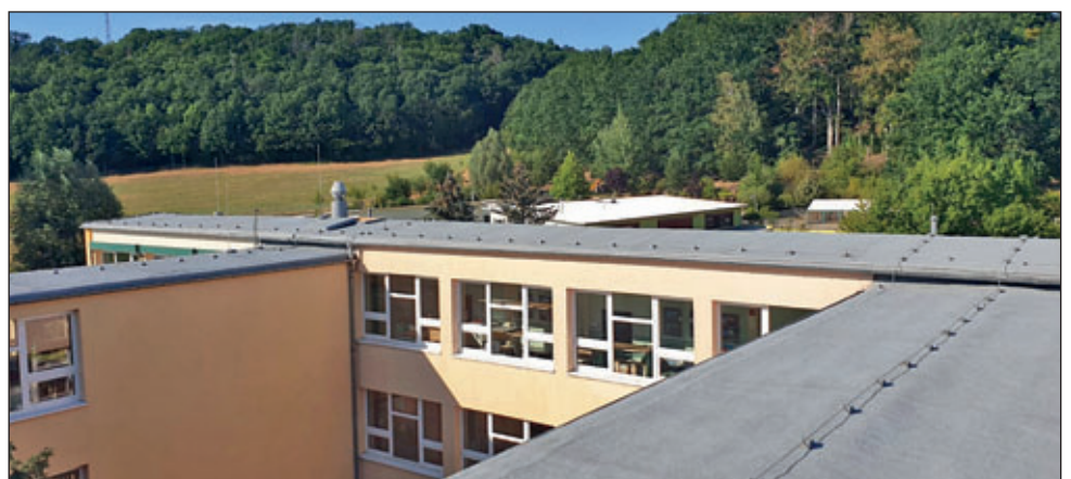
Die Oberschule hat in der Vergangenheit eine Dachsanierung mittels PUR-Hartschaum erhalten. Darauf ist ein Schutzanstrich gegen UV – Strahlung und Aufbringen von Splitt erforderlich. Dieser Anstrich wurde auf der gesamten Dachfläche ausgeführt.
