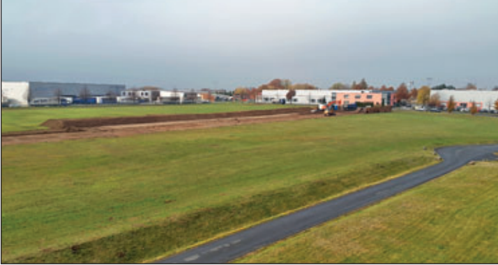
Baustand im November 2019
