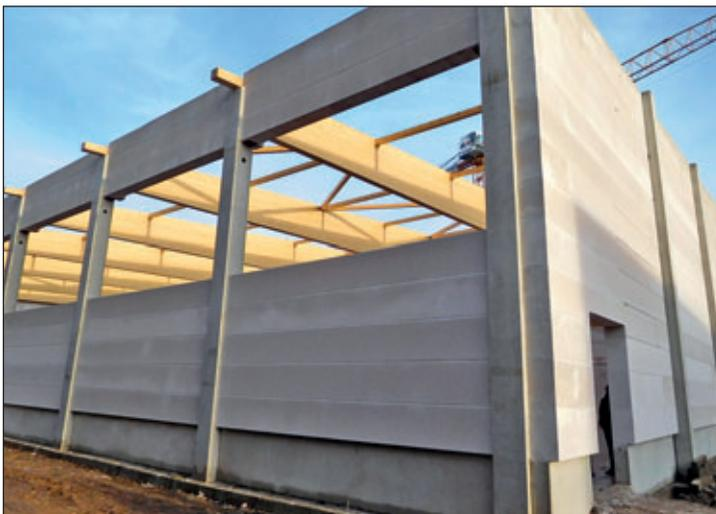
Nach der Montage der Wandplatten nimmt man die Größe der Halle zunehmend wahr. In die großen Öffnungen im oberen Bereich werden Fenster – Elemente eingebaut. Damit erhält der Hallenbereich ausreichend Tageslicht und die Möglichkeit der natürlichen Lüftung.
