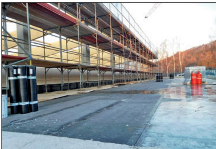
Die Dachfläche des Sozialbereiches ist zur Hälfte abgedichtet. Der Reif in den schon kalten Nächten zwang die Dachdecker zur Unterbrechung ihrer Arbeiten. Soll in den Wintermonaten weitergebaut werden, muss das Gebäude geschlossen und dicht sein.
