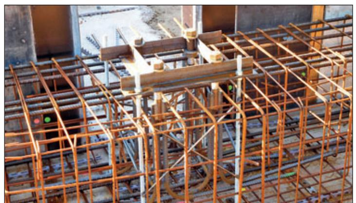
Das Foto zeigt eine Stelle des Fundamentes, auf die im September eine Stütze montiert wird. Die neue Sporthalle wird 20 Stützen erhalten. Bevor der Beton die gesamten Bewehrungseisen umhüllt und damit verdeckt, prüft das Ingenieurbüro Vogel aus Dresden, welches die statischen Berechnungen erstellt hat, ob auch alle vorgegebenen Eisen richtig eingelegt und miteinander verbunden sind.
