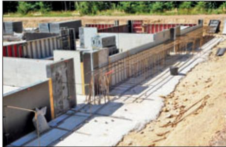
Im Foto links sind die ausgefrästen Bohrköpfe zu sehen, welche nun in die geplanten Gründungstreifen eingefasst werden. Die Bewehrungseisen der Pfähle werden mit denen der Gründungstreifen, welche gitterförmig hergestellt werden, verbunden.
