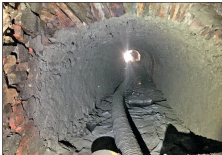
Spritzbetonarbeiten unter Tage
