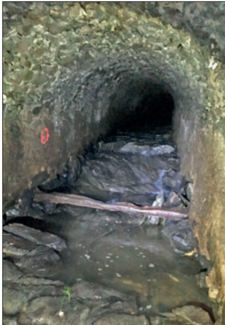
Auskolkungen im Sohlbereich werden mit Natursteinen ausgesetzt
